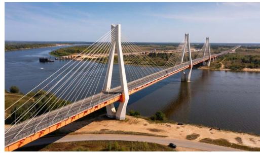
(a) Alpha Actual Bridge
